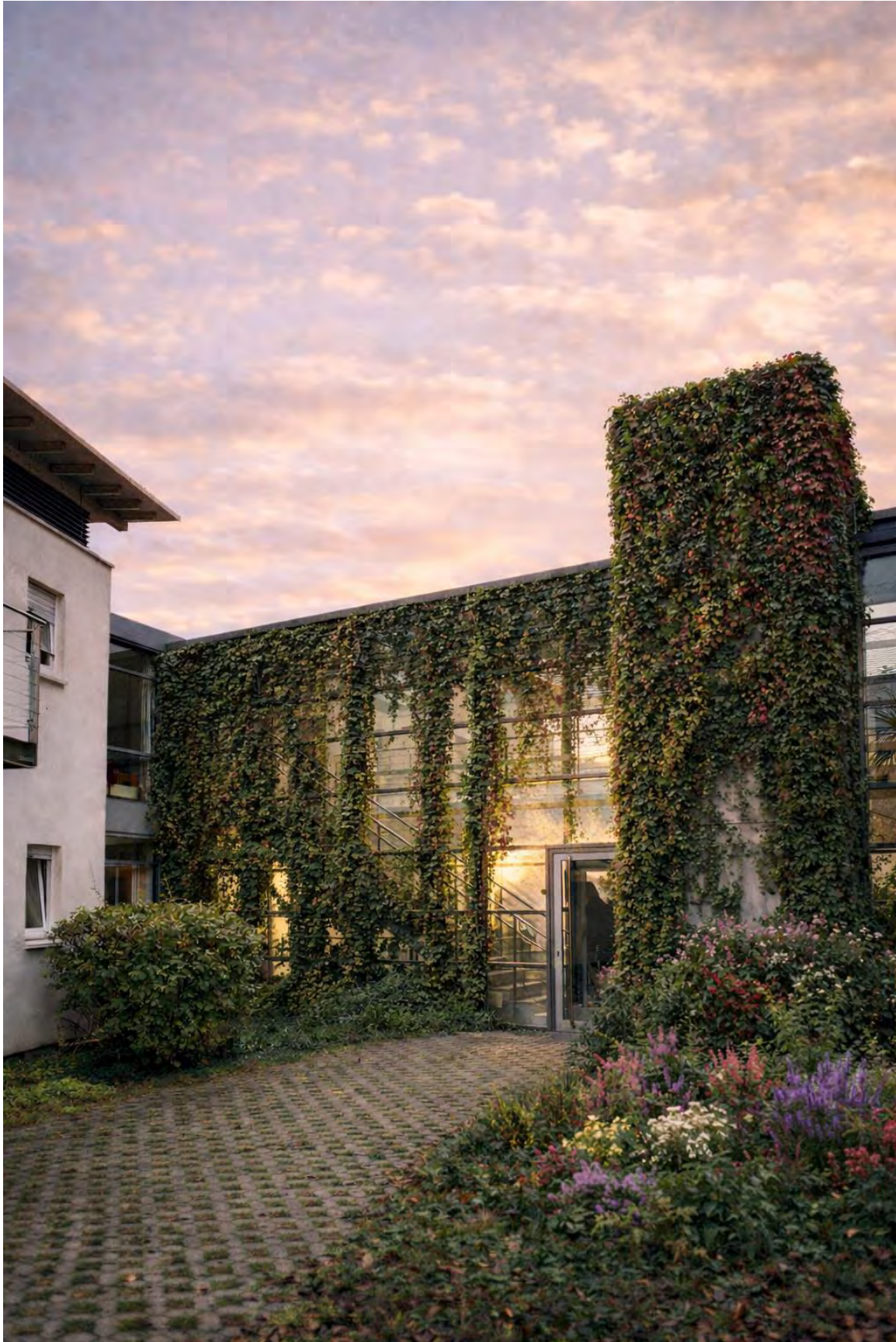
Abb. 27: Bodengebundene Begrünung mit Wuchshilfe am Beispiel des Hector Hauses
