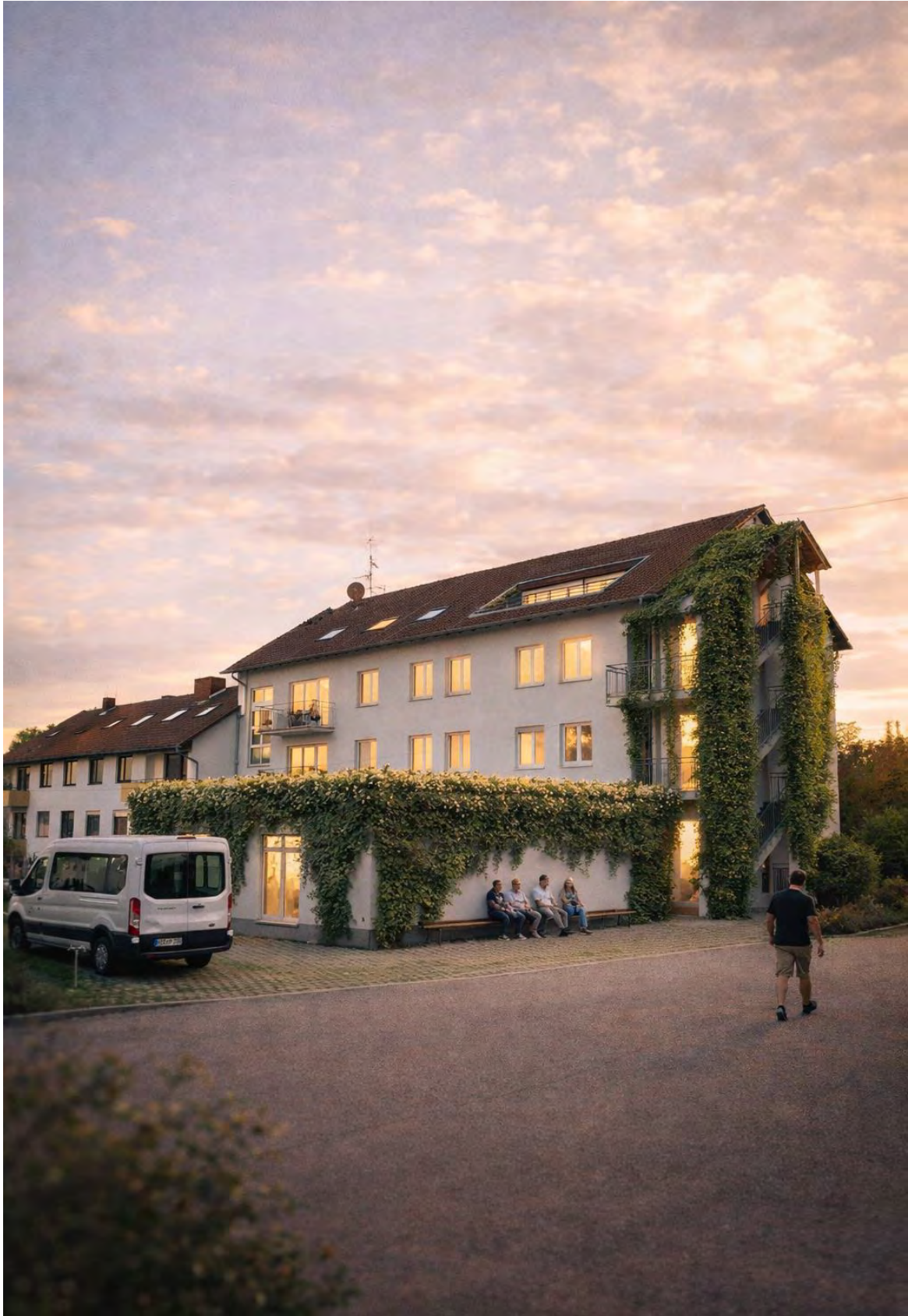
Abb. 25: Bodengebundene Begrünung mit Wuchshilfe am Beispiel des Verwaltungsgebäudes
