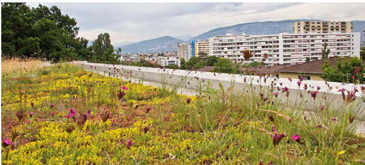
Abb. 29: Beispielbild einer extensiven Dachbegrünung
