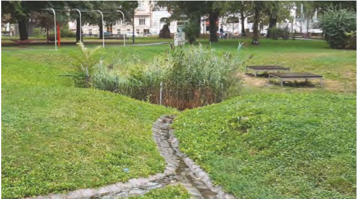
Abb. 33: Versickerungsmulde für Niederschlagswasser
