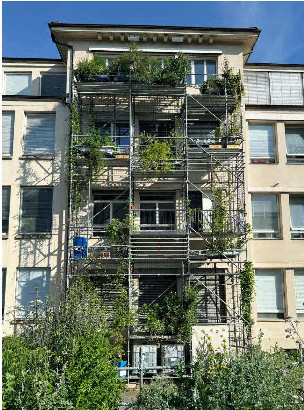
Abb. 28: Fassadenbegrünung mittels vorgestelltem Tragsystem
