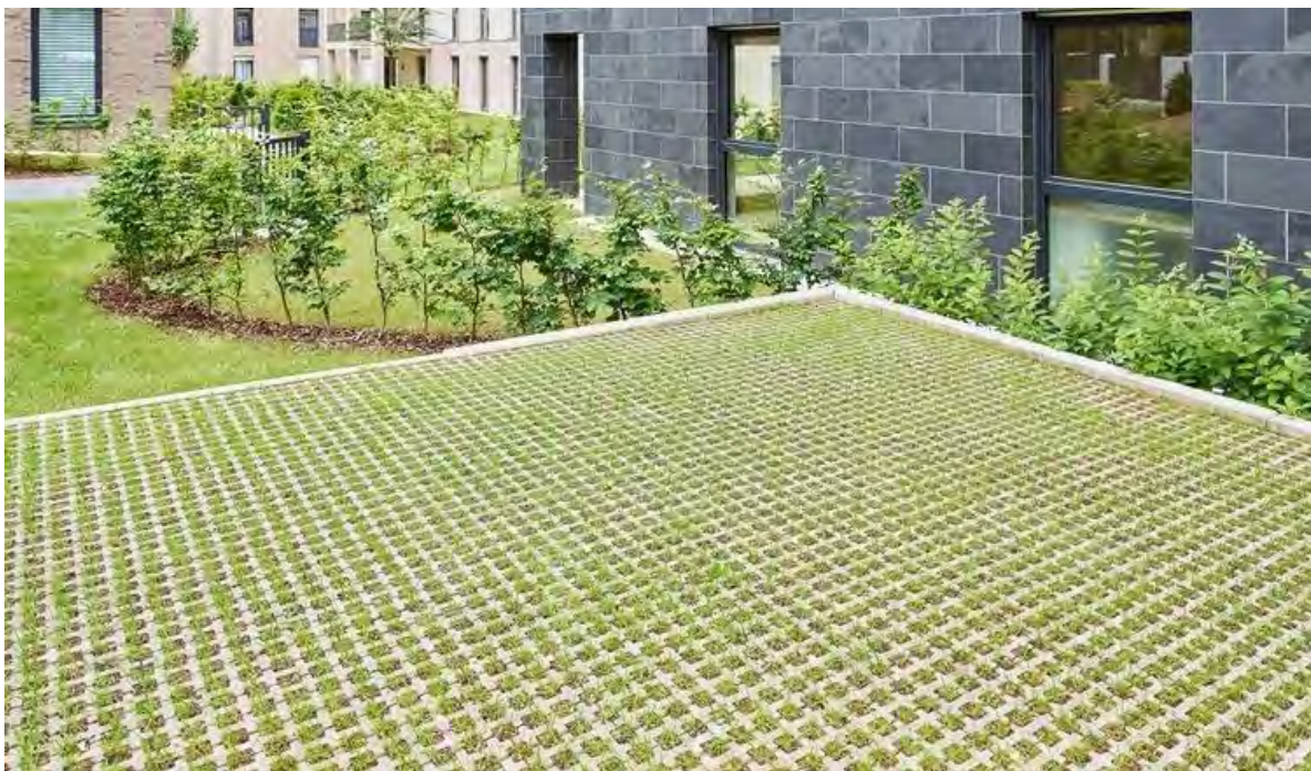
Abb. 32: Beispielbild einer Stellplatzfläche mit Rasengittersteinen
