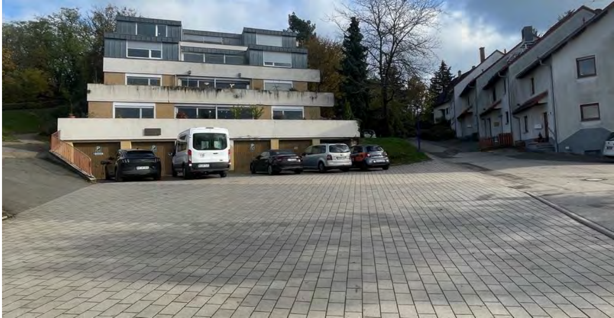
Abb. 36: Versiegelte Fläche auf der Westseite des Elisabeth-Weiß-Hauses (Terrassenhaus)
